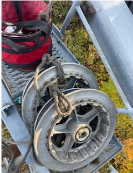
・支柱索輪交換
